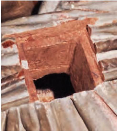
5 cm. de lado en el que el tornillo va empotrado y enroscado con absoluta fiabilidad. Para ello, se hace un taladro en la parte posterior del paño de pureza a fin de introducir la referida pieza.
